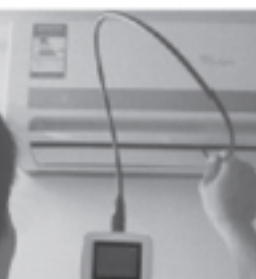
エアコンの点検
