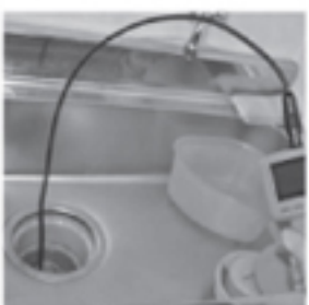
排水管の点検
